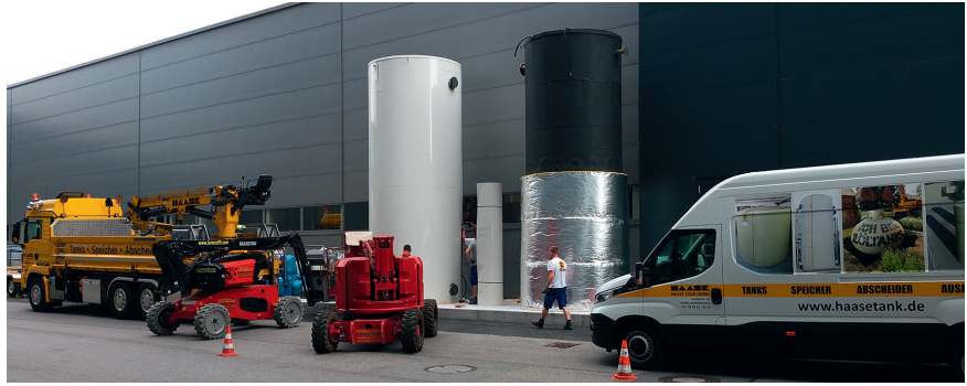
Bild 3. Montage gedämmter GFK-Wärme- und Kältespeicher, die in Kombination mit Wärmepumpen Prozesswasser eines Fruchtsaftherstellers heizen und kühlen (© Haase Tank)
